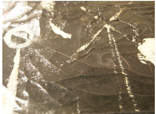
【表・部分】亀裂
