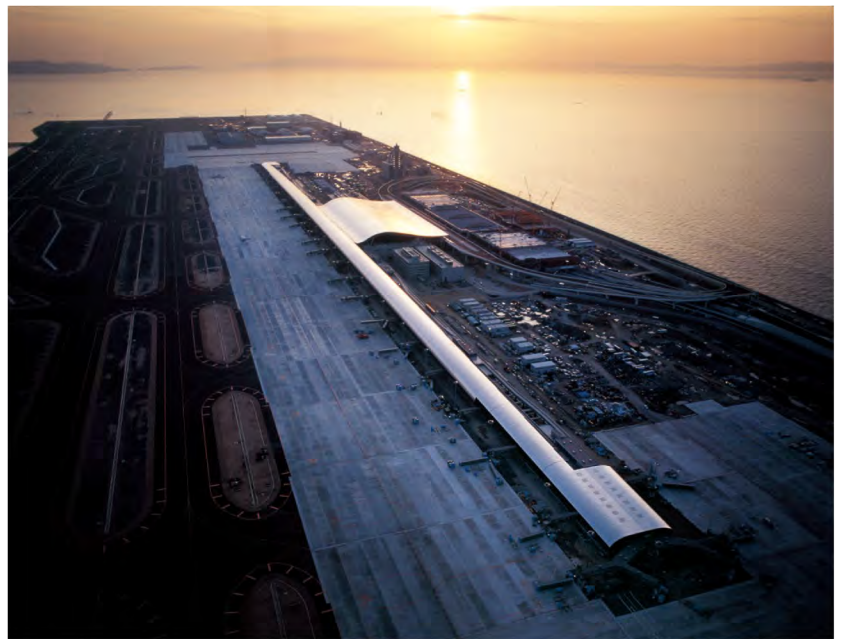
レンゾ・ピアノ「関西国際空港旅客ターミナルビル」(1988-1994年)1994年 © Fondazione Renzo Piano © Kansai Airports © Kawatetsu
